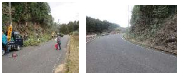
苜口自治会の伐採作業中 作業後
