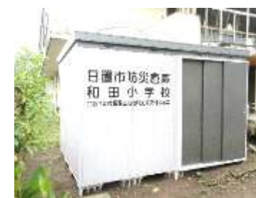
非常用備品を収納していきます
