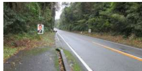
自歩道が途中で未整備に、路肩も狭く危険
